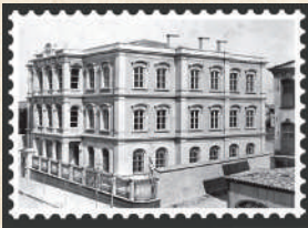
Rauf Paşa Konağı (1885)
