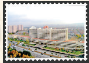
Sayıştay Hizmet Binası (2002- )
