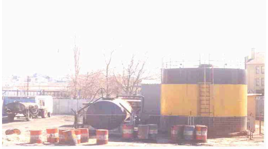
Gemilerden alınan sintineler fotoğrafta görülen tanklarda toplanıp dinlendirme metodu ile ayrıştırılmaktadır (Haydarpaşa Limanı)
